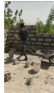
Aufstockung im Bau
